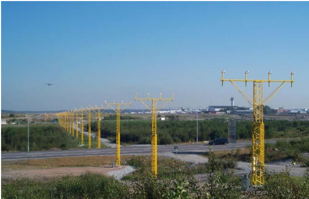
Figura 2-6-2. Torres de iluminación de aproximación — Estructuras reticulares de fibra de vidrio (Fuente: LAR 154 3ra edición 2020)
