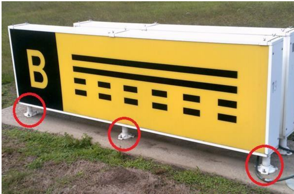
Figura 2-6-5. Ejemplos de cuplas Frangibles en las instalaciones del PAPI (Fuente: LAR 154 3ra edición 2020)
